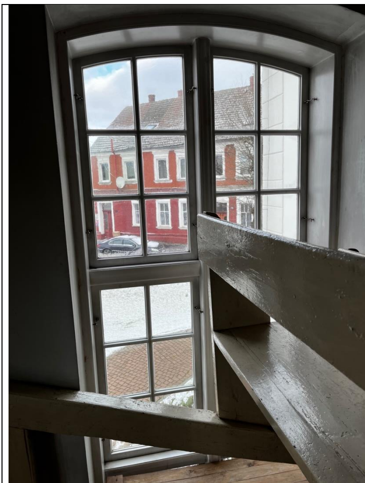
2) Wymiana popękanych szyb w oknach szkłem walcowanym, szt.19
