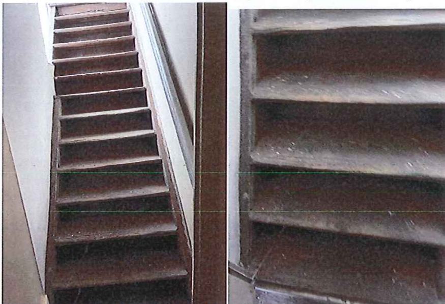
Remont dwóch biegów schodowych - wejście na chór prawy i chór lewy.
