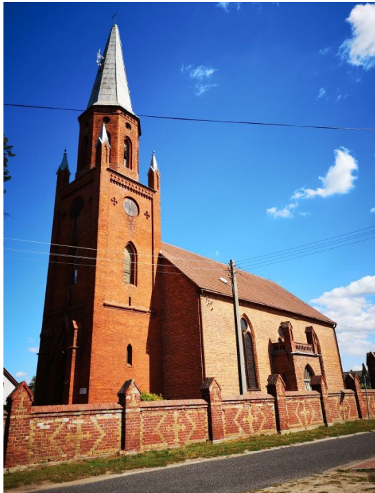
2. Widok od strony zachodnio-południowej w kierunku wschodnim
