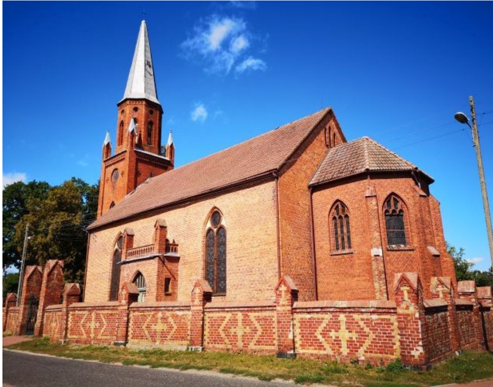
3. Widok na prezbiterium i elewację południową
