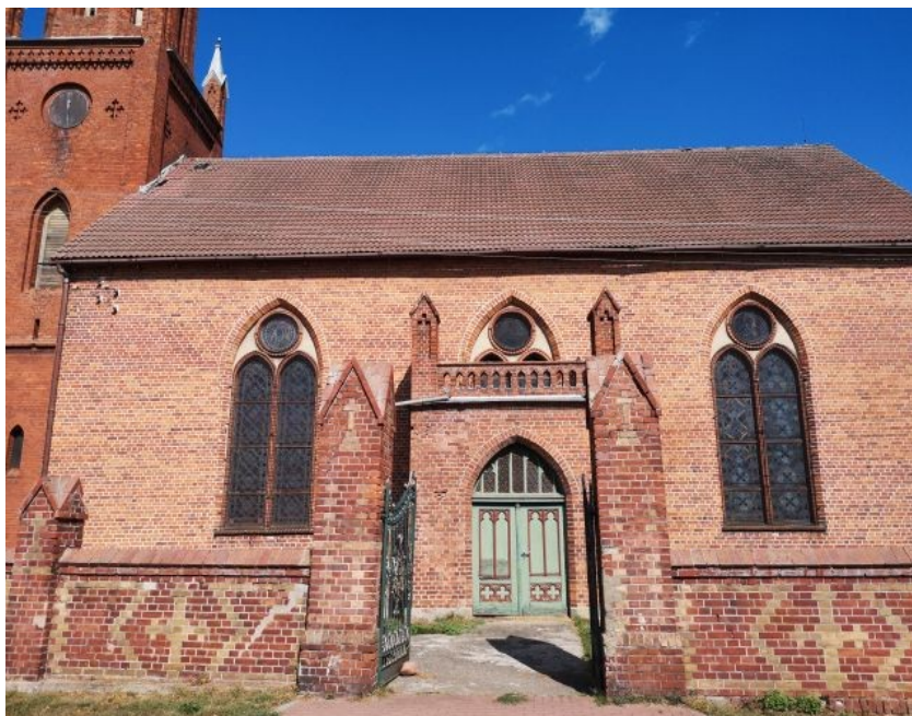
6. Elewacja południowa – portal
