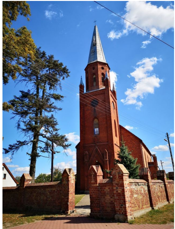
1. Widok kościoła od strony zachodniej
