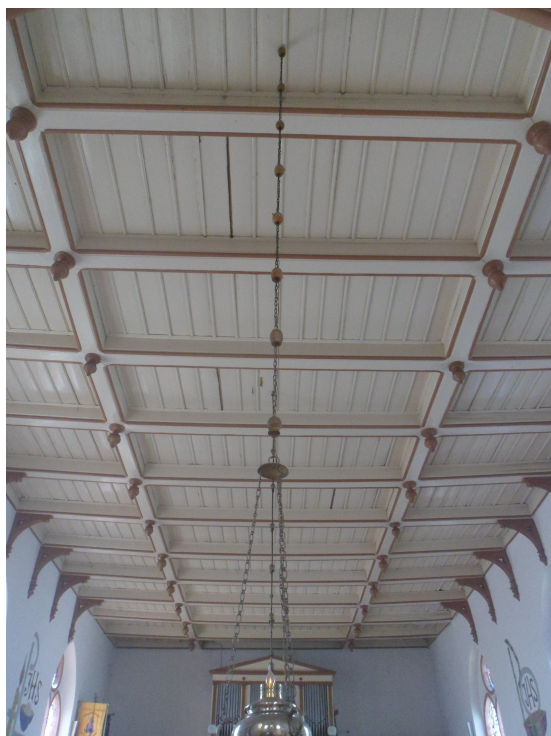
FOT.3. WIDOK STROPU OD STRONY WNETRZA KOŚCIOŁA
