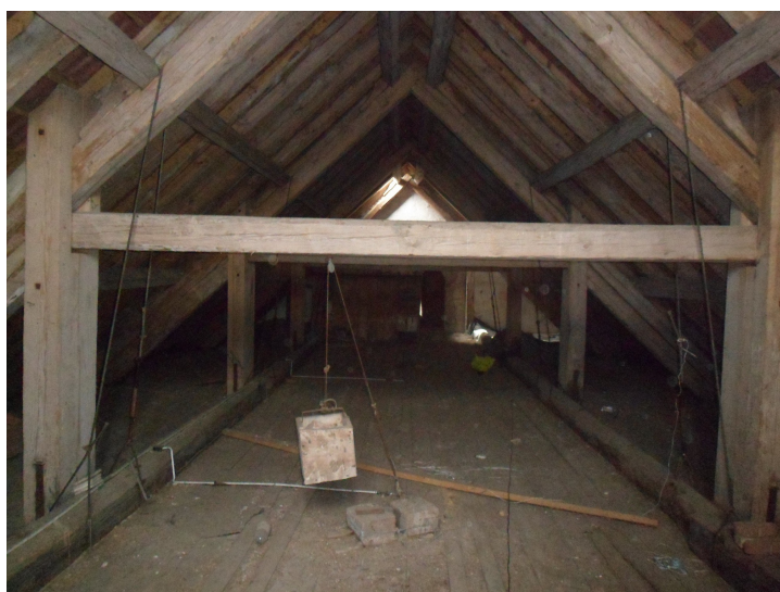
FOT.2. WIĘZBA DACHOWA
