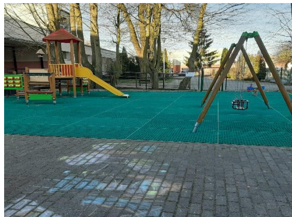
Stan po wykonaniu nawierzchni
