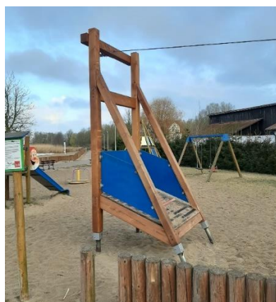
Stan po remoncie
